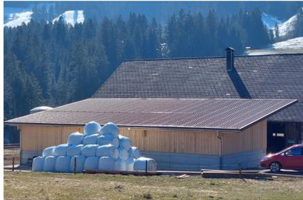
Umgedeckt mit **Wellblech** Sandwichpanel ISOPAN, Typ Isovola PIR, Wellprofil 50/200, Dicke 60mm, Farbe RAL 8017 braun matt, Innenseite grauweiss
