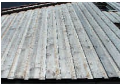
Abb. 7: Detail Deckbretterschirm,
