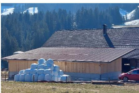
Remplacement de la couverture: **tôle ondulée**, panneaux sandwich ISOPAN, de type Isovela PIR, profil ondulé 50/200, épaisseur 60 mm, couleur RAL 8017 brun mat, intérieur blanc-gris
