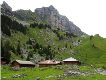
Le fait que les couvertures de toit soient juxtaposées sans être assorties (clarté et matériau) dégage une impression dérangeante. La bande plus claire sur la toiture du milieu renforce cette impression.
