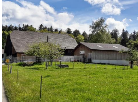
Les deux toitures, voisines, l'une en tuiles en terre cuite et l'autre en fibrociment ondulé, sont bien assorties: couleurs mates, structures de petite taille et matériaux qui se patinent rapidement.
