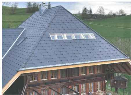
Le toit se distingue trop nettement (couleur et degré d'érosion) du bâtiment et du paysage.
