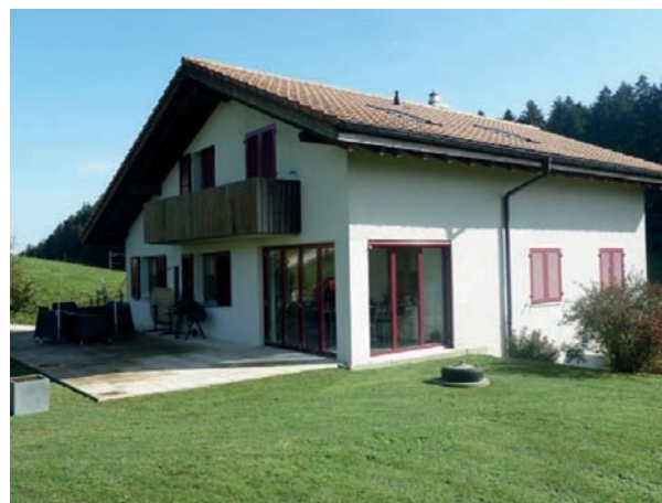
Vitrage d'un renforcement de bâtiment
