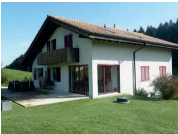
Vitrage d'un renforcement de bâtiment
