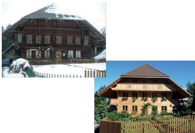
Reconstruction d'une petite ferme après sa démolition
