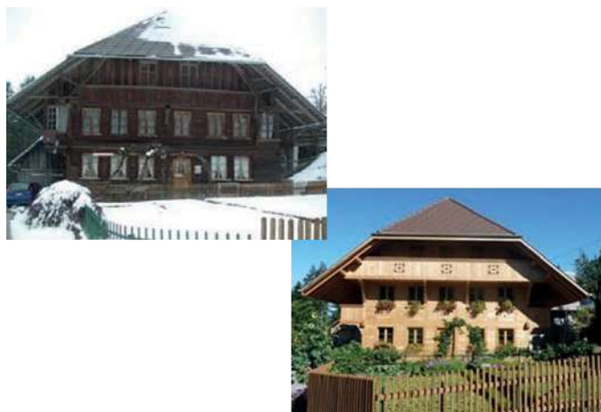
Reconstruction d'une petite ferme après sa démolition
